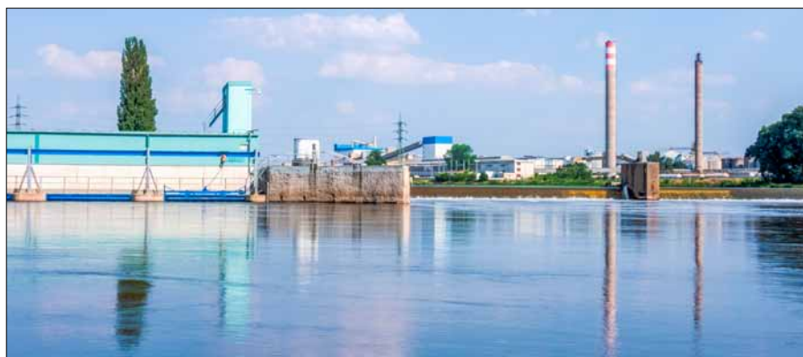
Obr. 1. Malá vodní elektrárna Píšťany
