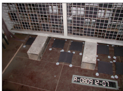
Obr. 4. Rám s textilními indikátory tepelných a tlakových účinků na mezipodlaží (používaly se již v roce 2009)
