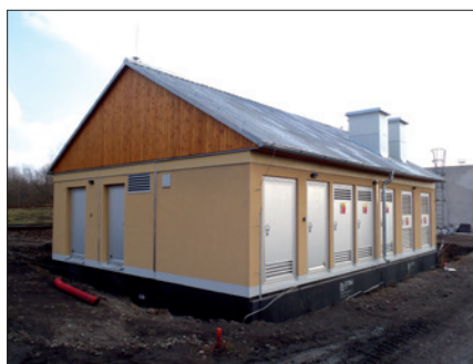
Obr. 4. Transformační stanice po montáži v železniční stanici Olomouc
