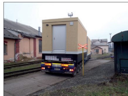
Obr. 6. Doprava části stanice Olomouc na místo stavby
