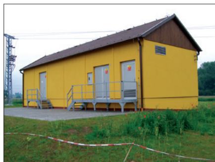
Obr. 1. Spínací stanice Bakov 22 kV
