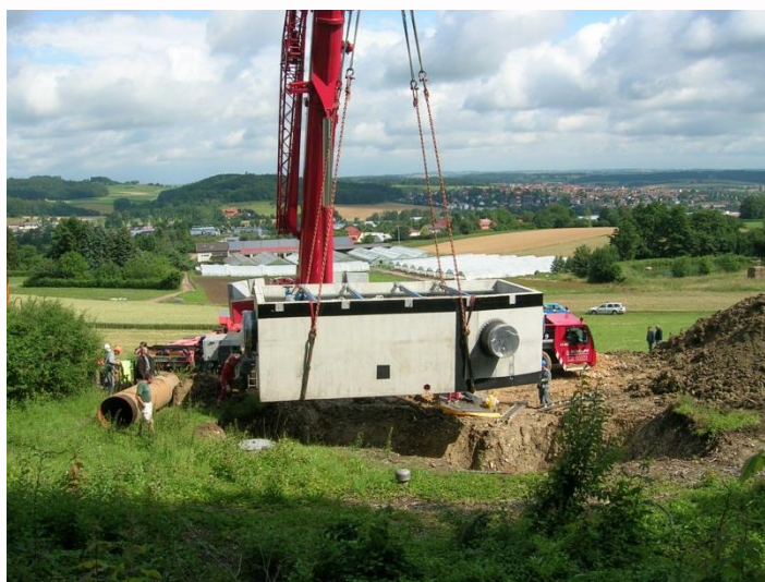
Obr. 23: Zdvihání betonové buňky pomocí textilních pásů
