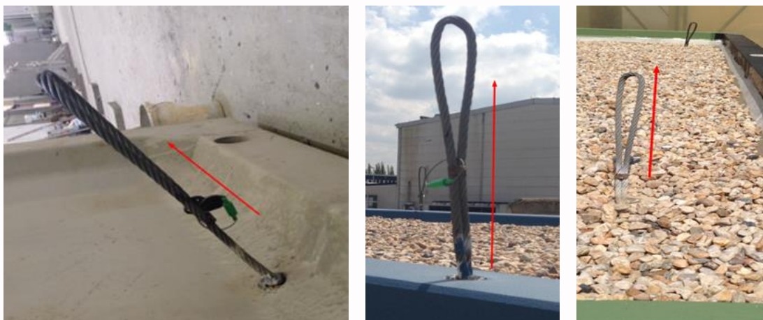
Obr. 24 Příklady dovoleného směru tahu
