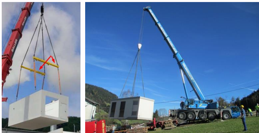
Obr. 19: Montáž se střechou a bez střechy
